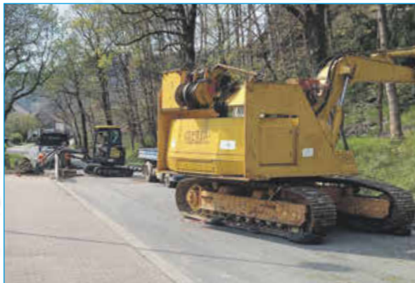
Der große Bagger vorn diente den Forstleuten als Widerlager für die mehr als 250 m lange Seilbahn, mit der die gefällten Bäume nach oben abtransportiert wurden. Im deutlich kleineren Baugerät im Hintergrund bewies ein ums andere Mal Philipp Euchler seine Fähigkeiten zu chirurgischen Eingriffen. Foto: Dirk Schöne
